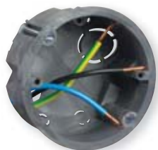
Montáž přijímače do instalační krabice
